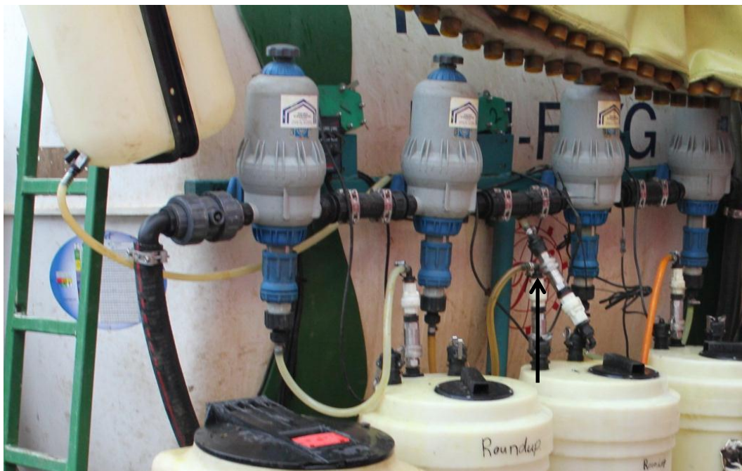
Billede 8. Koblingen fra injektionspumpen flyttes fra sprøjtemiddeltanken til en slange fra rengøringstanken.
